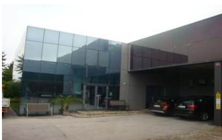
Sončna elektrarna B 92 Ljutomer
